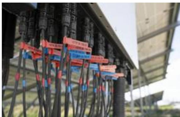
Ces étiquettes au format drapeau en polyuréthane imprimables, résistent aux environnements extrêmes et sont parfaitement adaptées aux applications photovoltaïques.
